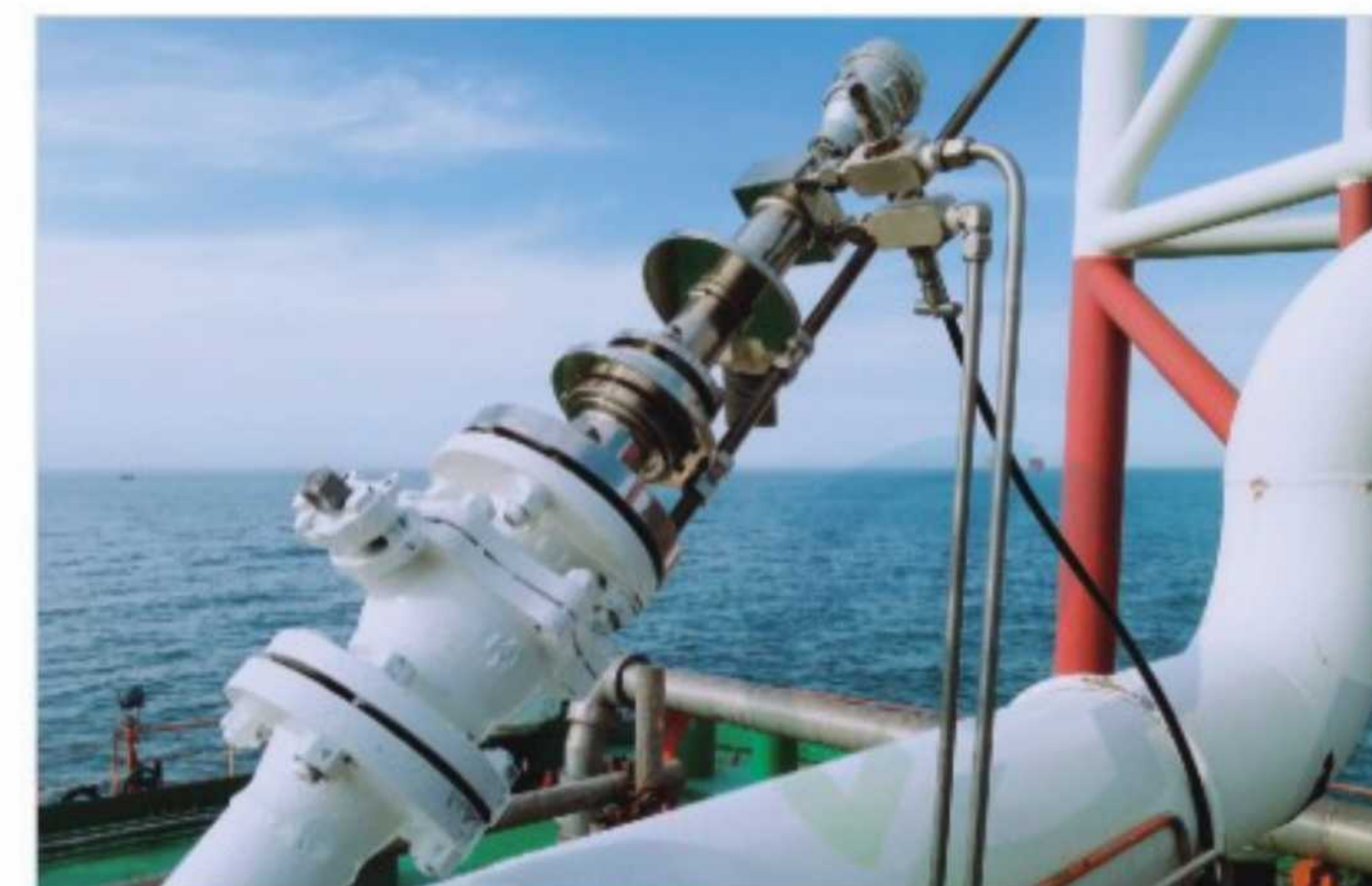
中海油QHD32-6渤海世纪平台 介质：放空宽量程火炬气 管外径×壁厚：φ530×10mm 压力：165kPa 温度：30℃
