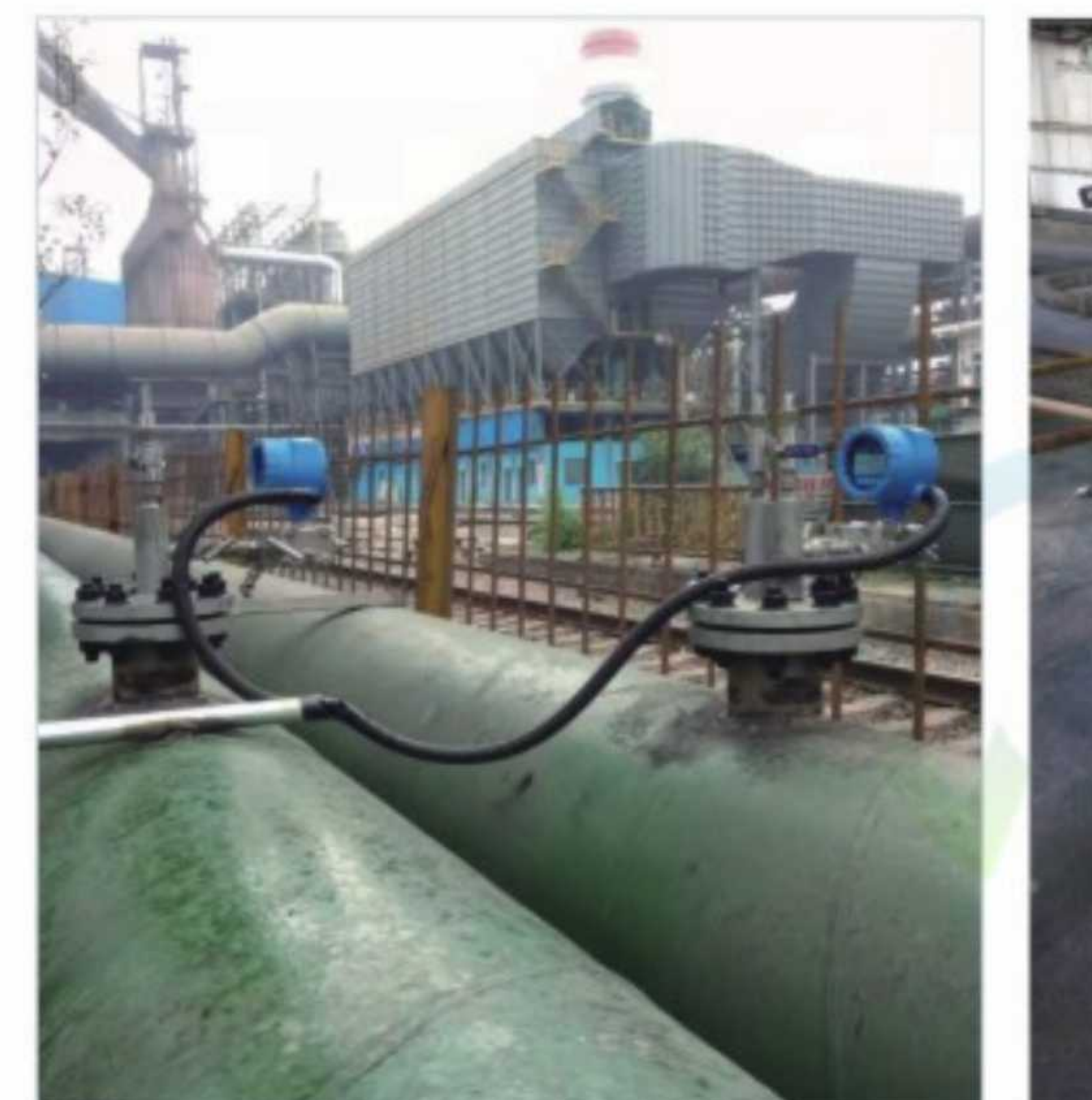
马鞍山钢铁股份有限公司 介质: 冲渣水 管外径×壁厚: \phi 630 \times 10 \text{ mm} 压力: 0.35MPa 温度: 60℃
