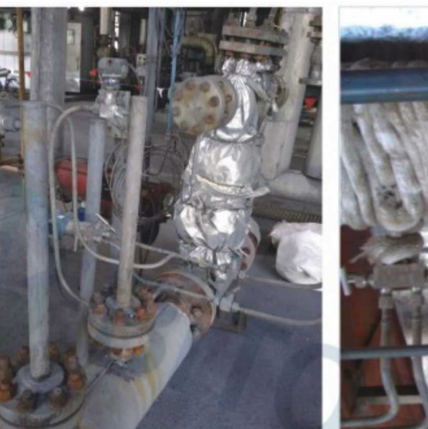
上海焦化有限公司 介质: 黑水 管外径×壁厚: \phi 159 \times 4.5 \text{ mm} 压力: 4MPa 温度: 115℃
