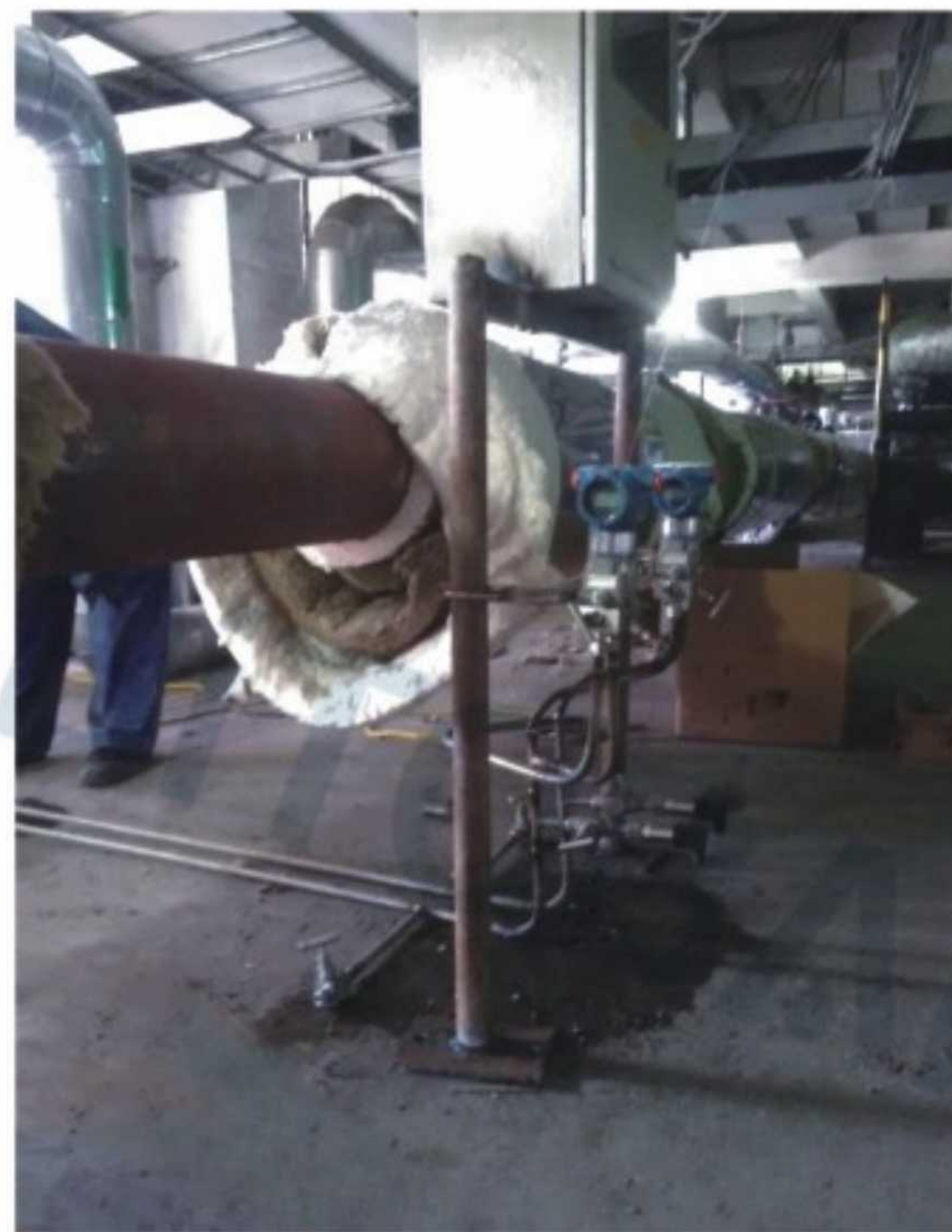
酒泉钢铁(集团)有限责任公司 能源中心一分厂 介质: 双向蒸汽 管外径×壁厚: \phi 426 \times 18 \text{ mm} 压力: 1.6MPa 温度: 350℃
