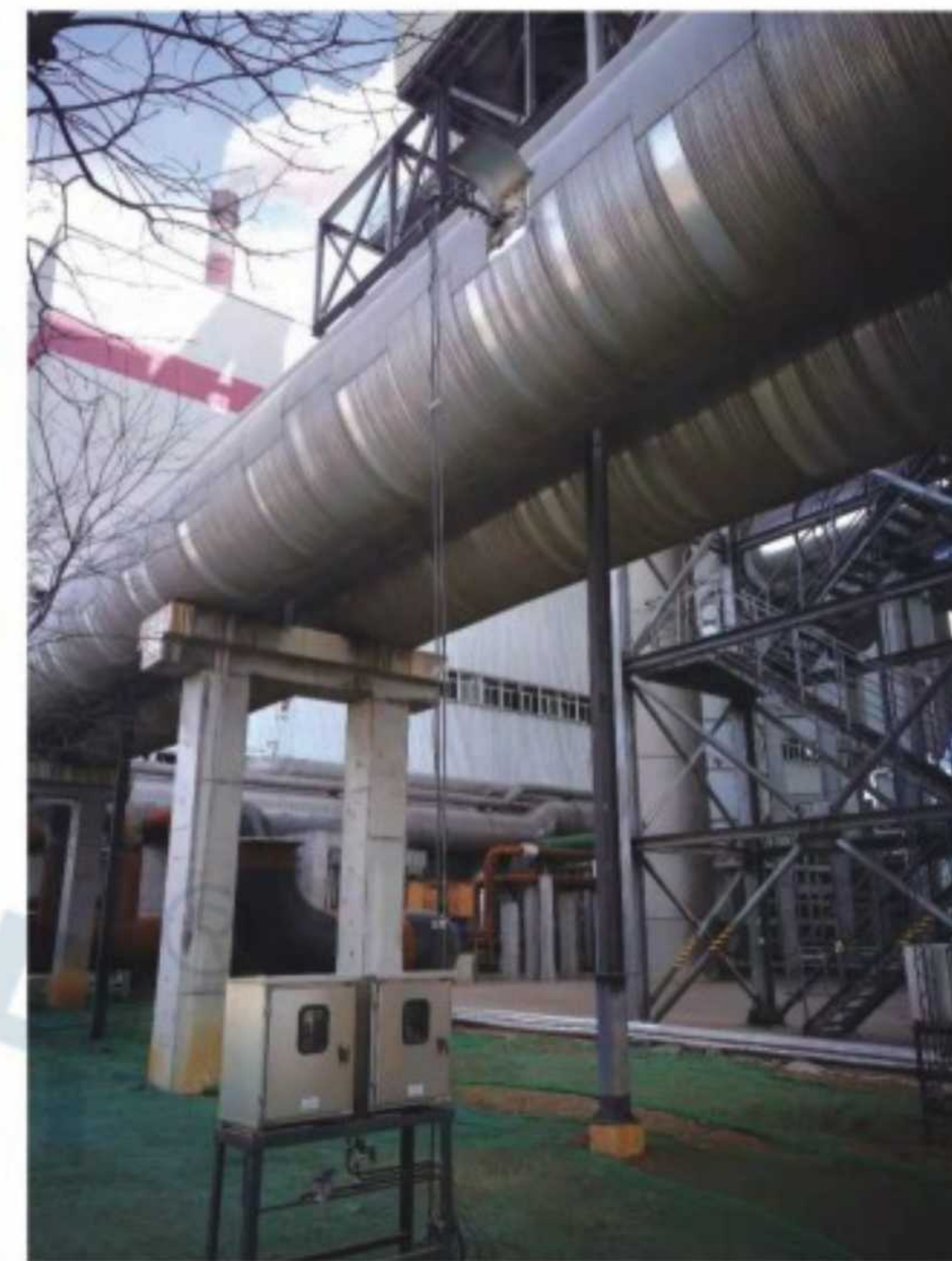
中煤华晋晋城热电有限公司 介质: 蒸汽 (贸易计量) 管外径×壁厚: \phi 1620 \times 14 \text{ mm} 压力: 0.7MPa 温度: 282℃
