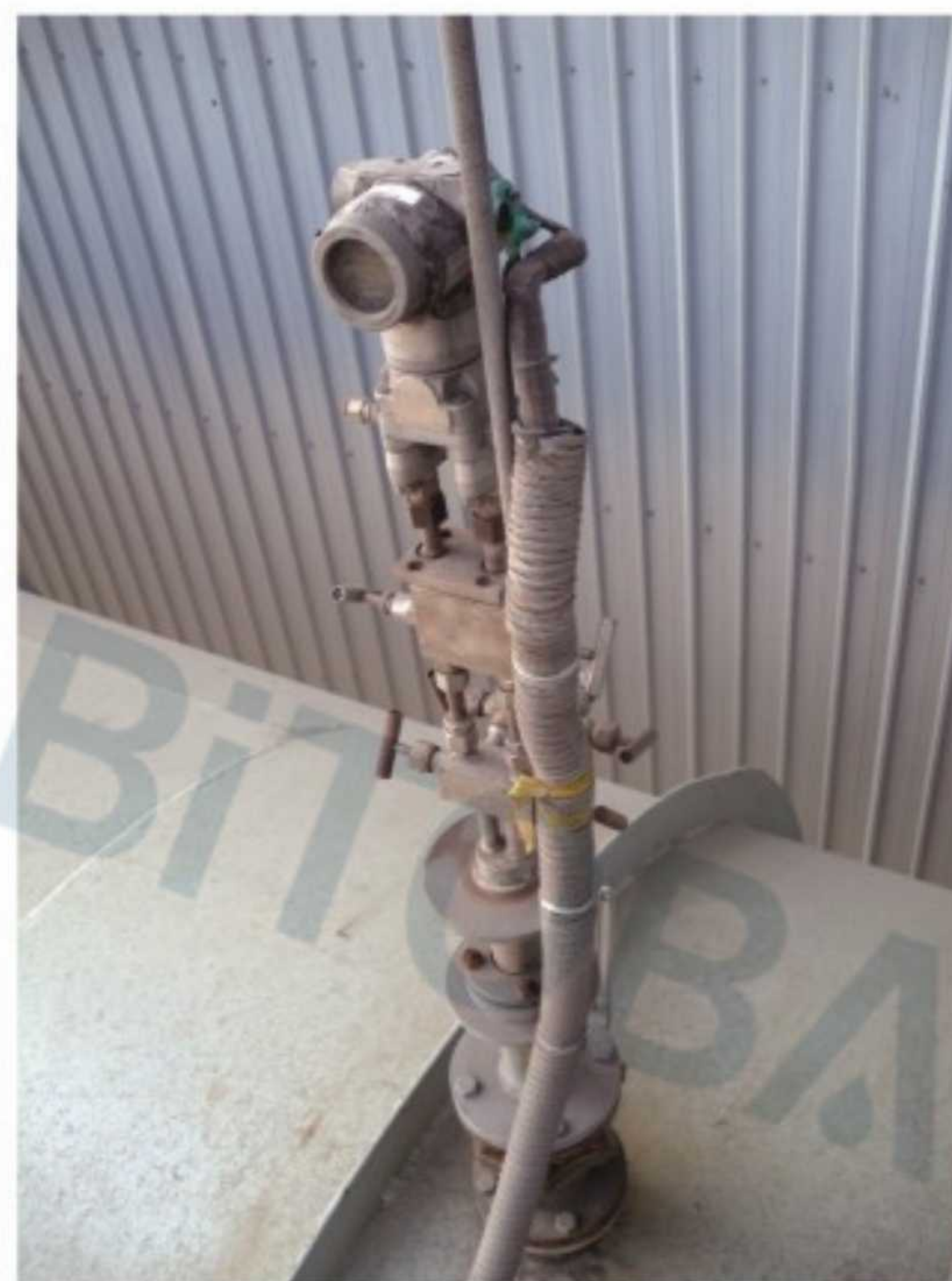
首钢京唐钢铁联合有限责任公司 介质：高炉煤气 管外径×壁厚：φ3020×10mm 压力：10kPa 温度：45℃
