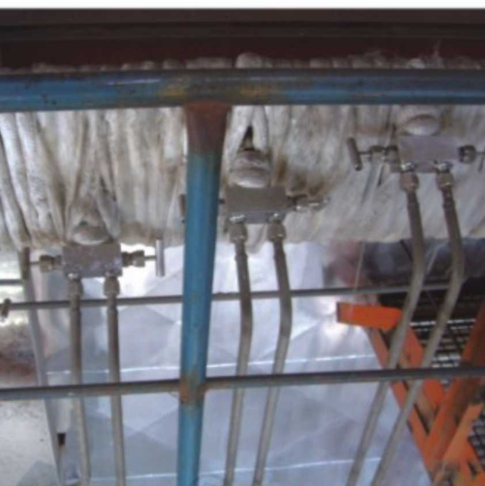
包头山晟新能源萨拉齐电厂 介质: 减温水 管外径×壁厚: \phi 27 \times 4 \text{ mm} 压力: 8MPa 温度: 215℃
