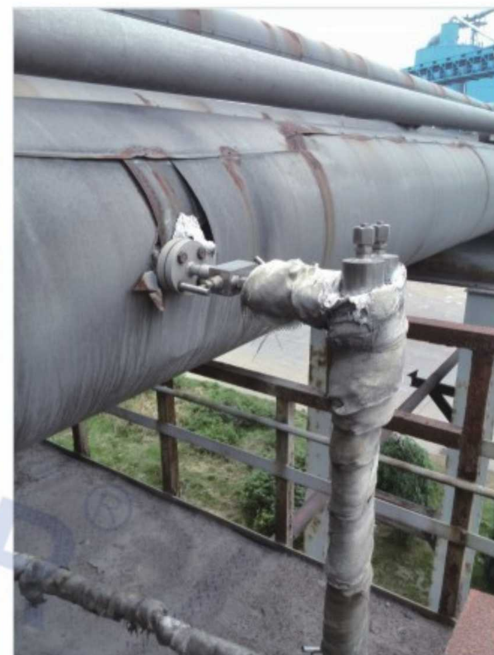
岳阳纸业股份有限公司 介质: 蒸汽 管外径×壁厚: \phi 426 \times 8 \text{ mm} 压力: 1MPa 温度: 215℃
