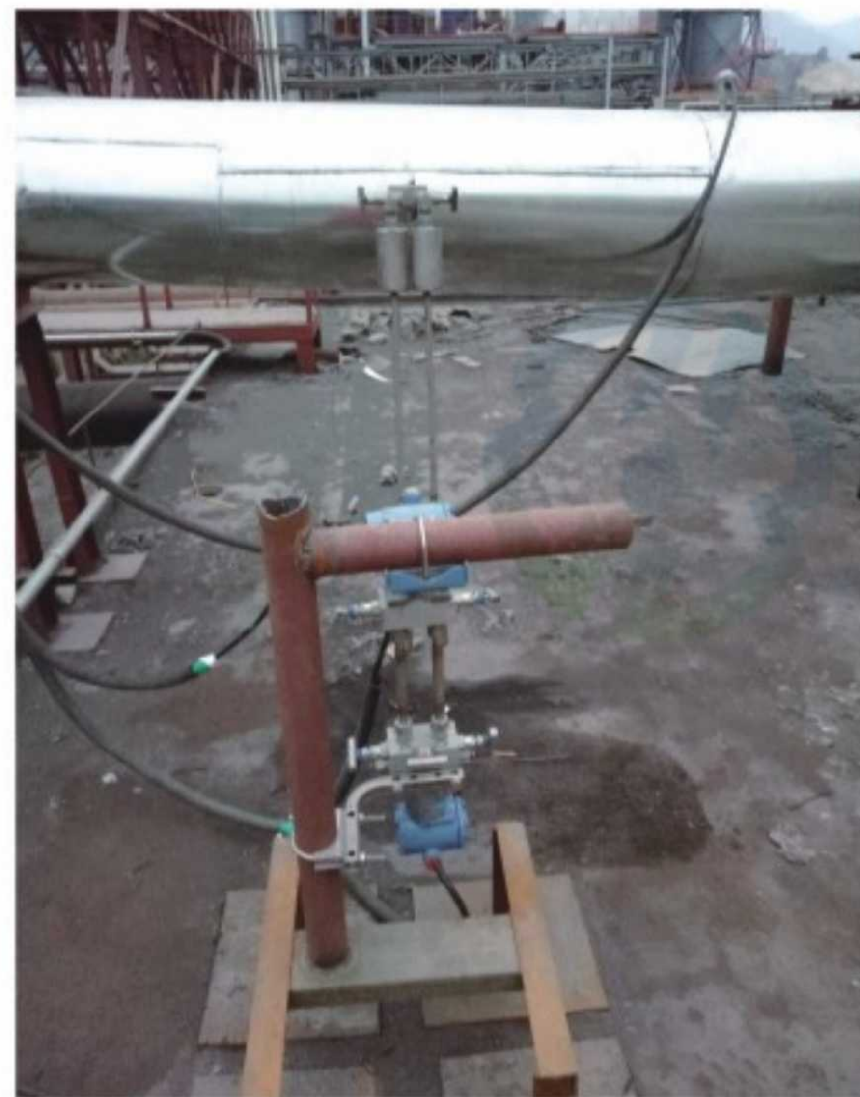
宝钢德盛不锈钢有限公司 介质: 宽量程蒸汽 管外径×壁厚: \phi 108 \times 4 \text{ mm} 压力: 1.6MPa 温度: 320℃
